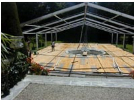
Plancher avec bâti sous structure
